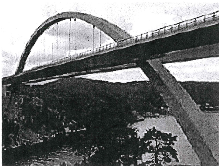
Svinesundbrua er ei buebru der buen er både over og under.
