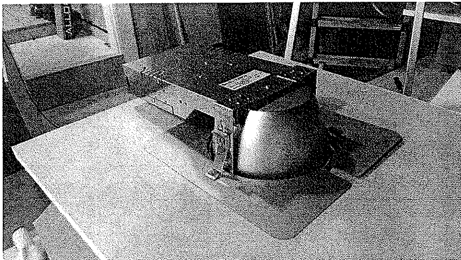
Lysarmaturen satt på plass på takplaten.
